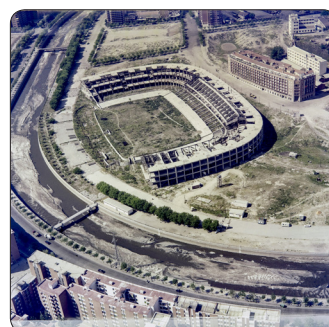
1965 Estadio Vicente Calderón en construcción
